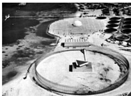
Trojúhelníkový vysílač Zeus Acquisition Radar je v popředí, v pozadí je přijímač zakrytý kupolí.
