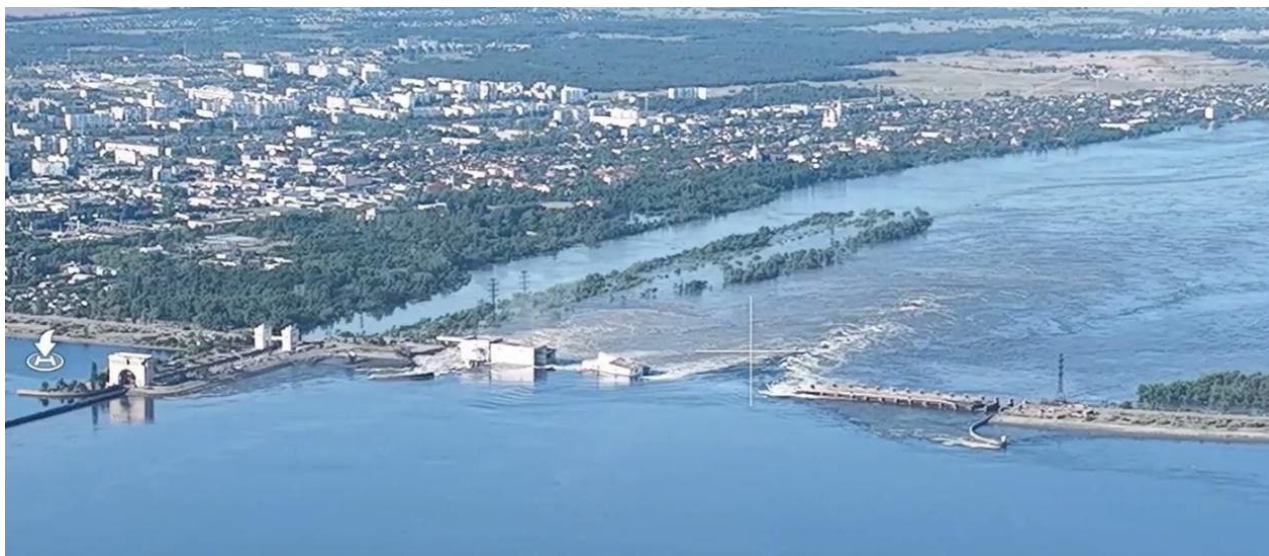
Zničená Kachovská přehrada
