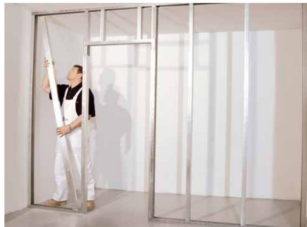
Montáž nosné konstrukce příčky – svislé profily R-CW
