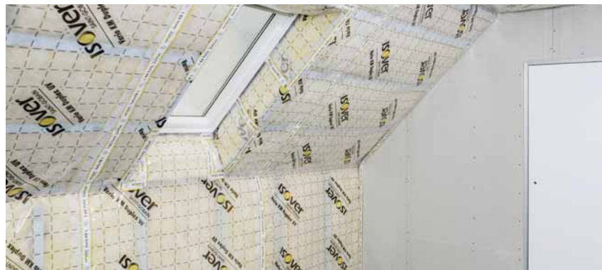
Podkroví po aplikaci parozábrany
