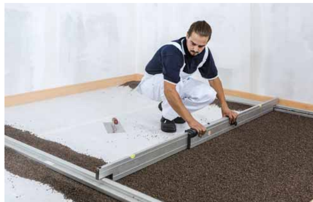
Výškové vyrovnání podsypu
