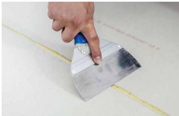
Seškrábnutí vypěněného polyuretanového lepidla
