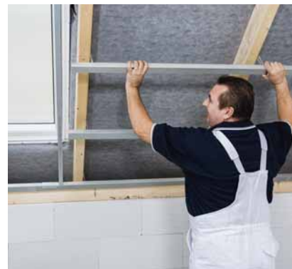
Montáž podkonstrukce – R-UD a R-CD profily spojeny samovrtnými šrouby typu LB
