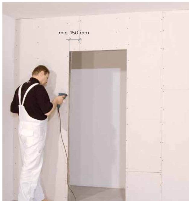
Montáž opláštění – druhá strana příčky
