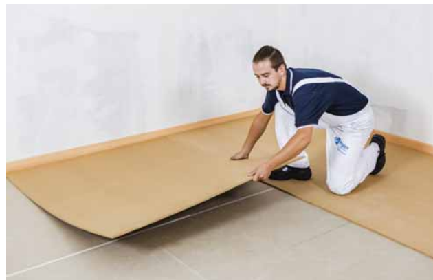
Pokládka izolantu (dřevovláknitých desek)
