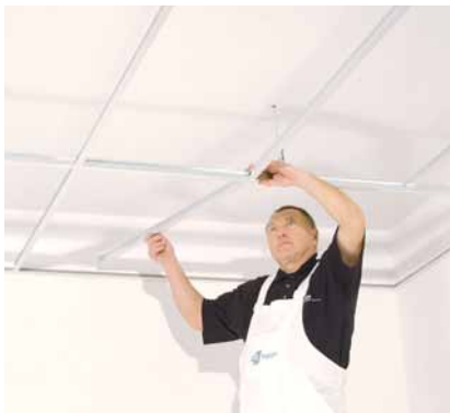
Osazení příčných profilů délky 1 200 mm
