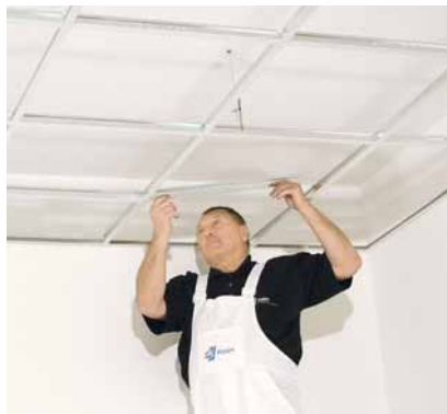
Osazení příčných profilů délky 600 mm
