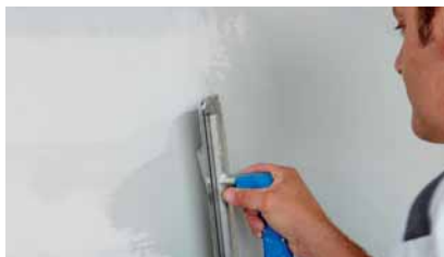
Roztážení a uhlazení tmelu
