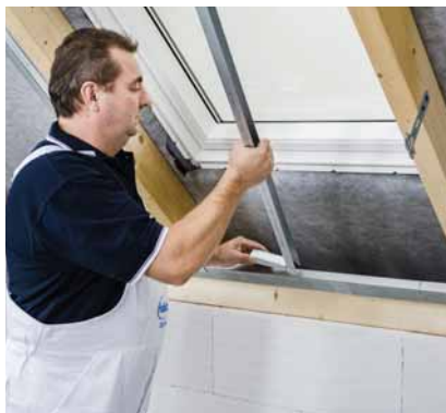
Výměna z R-UD profilu nasunuta mezi spodní a vrchní R-CD profil
