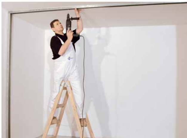
Montáž nosné konstrukce příčky – obvodové profily R-UW
