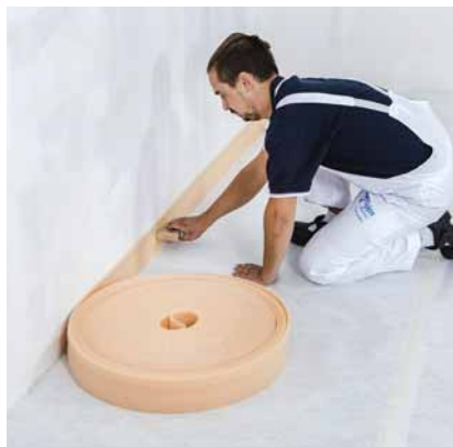
Přípevnění okrajových pásků
