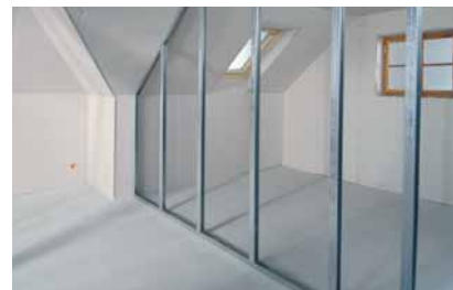
Osazení R-CW profilů
