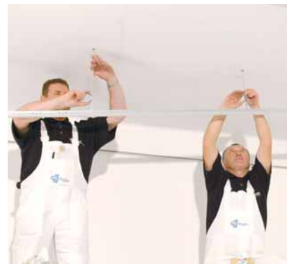
Osazení hlavních T-profilů
