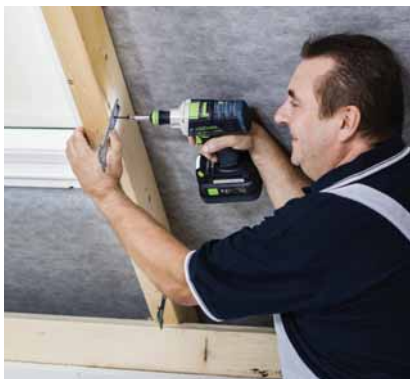
Přípevnění závěsů do dřevěných krokví
