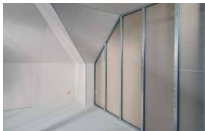
Opláštění příčky z jedné strany
