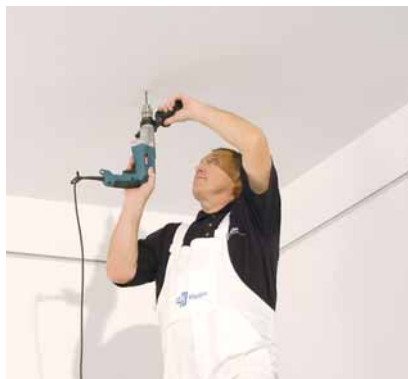
Kotvení závěsů do nosného stropu
