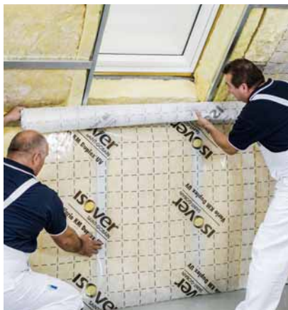
Instalace parozábrany – parozábrana na podkonstrukci
