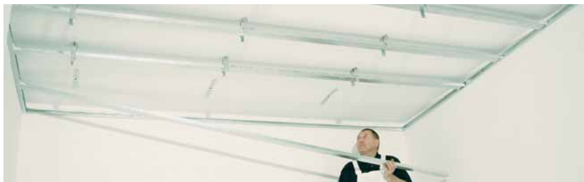
Osazení montážních R-CD profilů opláštění stropu
