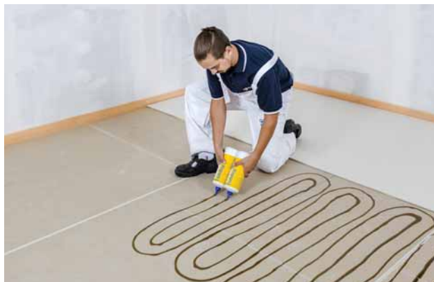
Prolepení desek podlahovým lepidlem Rigidur
