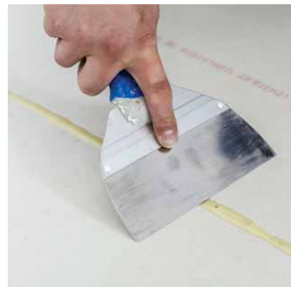
Stržení vypěněného polyuretanového lepidla
