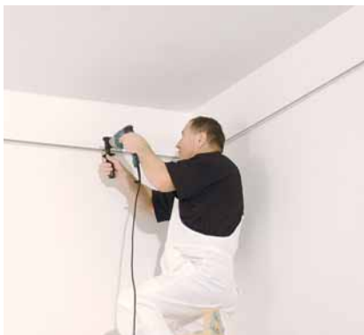
Montáž obvodových profilů
