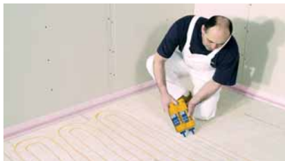
Nanášení lepidla v pruzích
