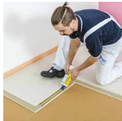
Nanesení podlahového polyuretanového lepidla
