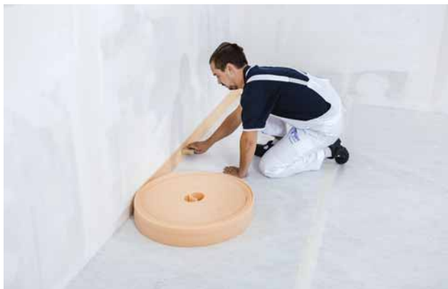
Aplikace obvodového pásku
