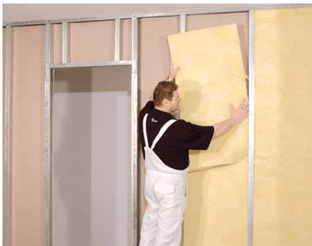
Vložení minerální izolace do dutiny příčky
