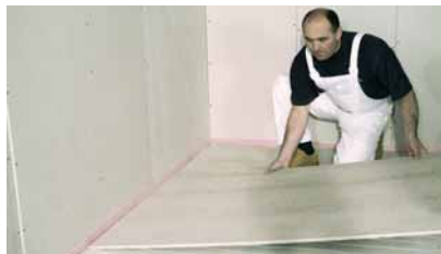
Pokládání druhé vrstvy desek
