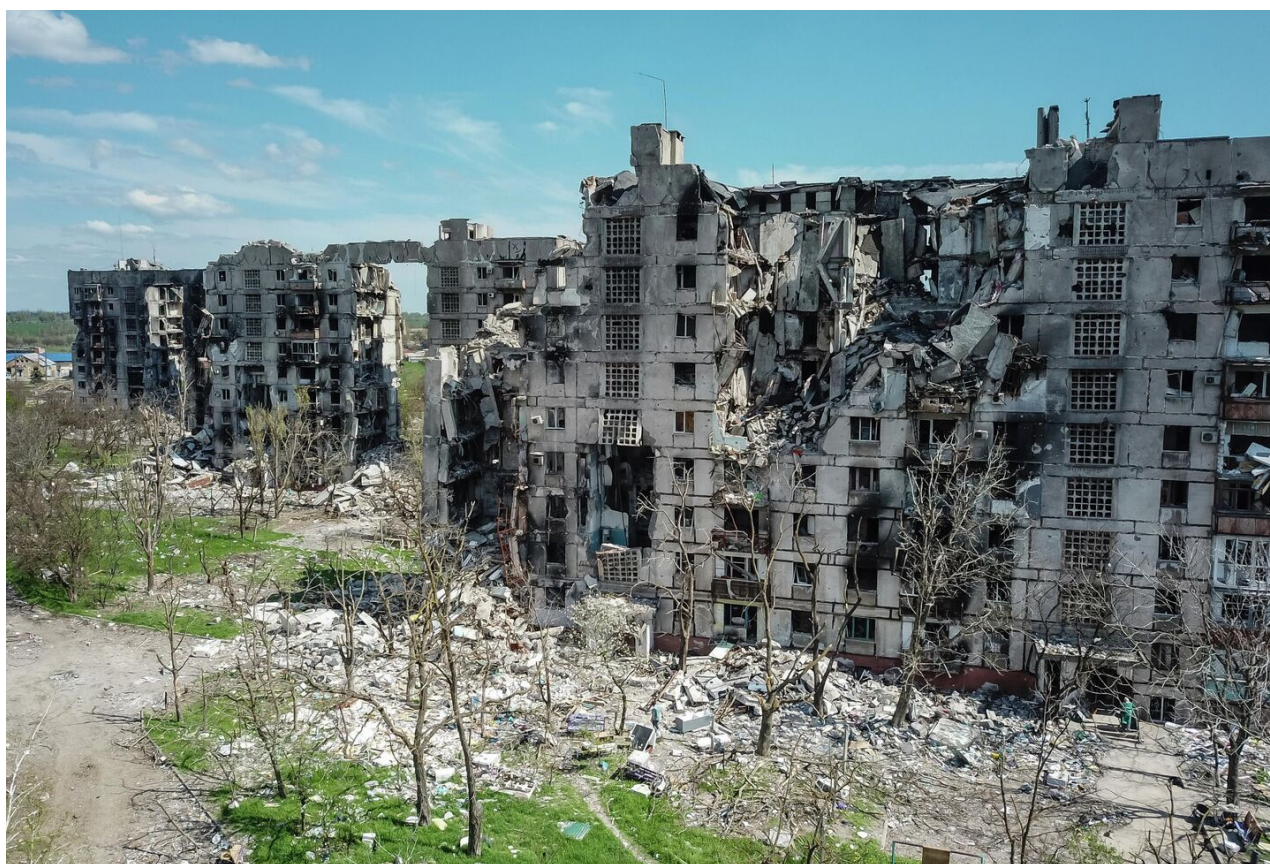
Разрушенные дома в Левобережном районе Мариуполя. 2022 год
