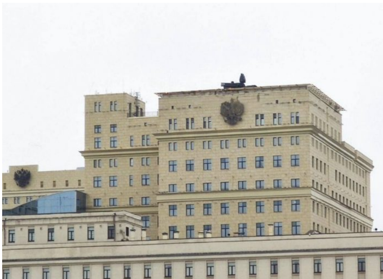
Pancir S1 na střeše ruského ministerstva obrany v Moskvě
