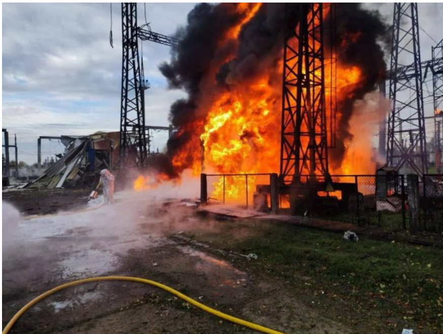
Následky po úderu raketou Kaliber na rozvodnu nedaleko Kyjeva
