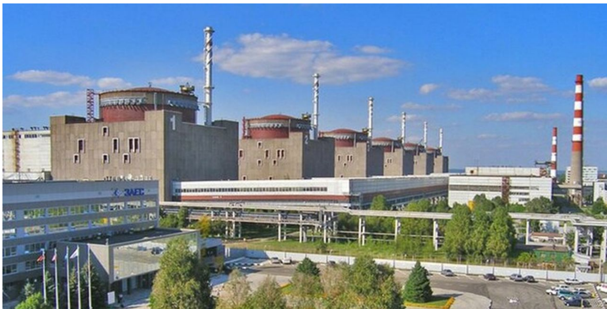
Výrobní bloky Záporožské JE v Energodaru
