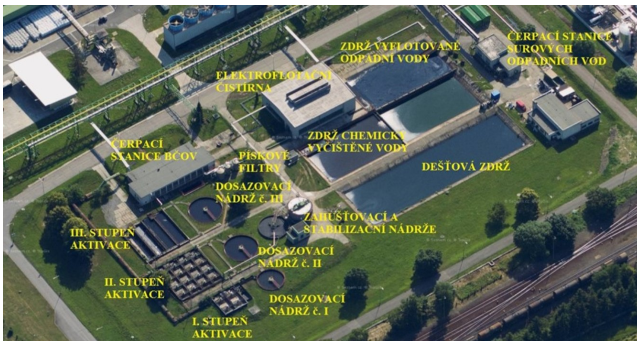
Obrázek 8 – Situace před výstavbou nové biologické čistírny odpadních vod 151
